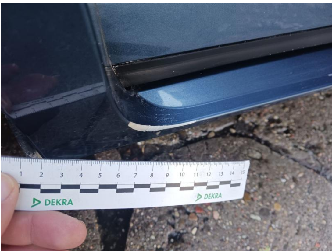
Fot. 34 Próg P - Rysa/odprysk 1
