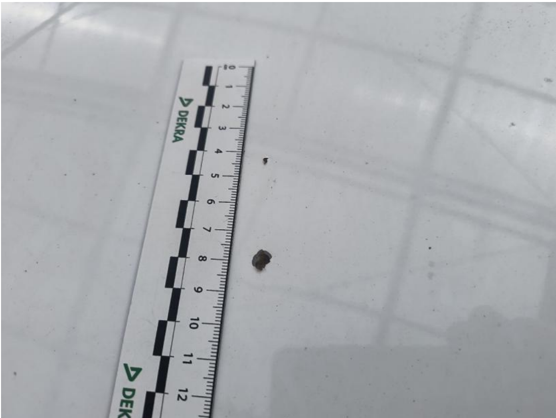
Fot. 77 Dach - Inne 2
