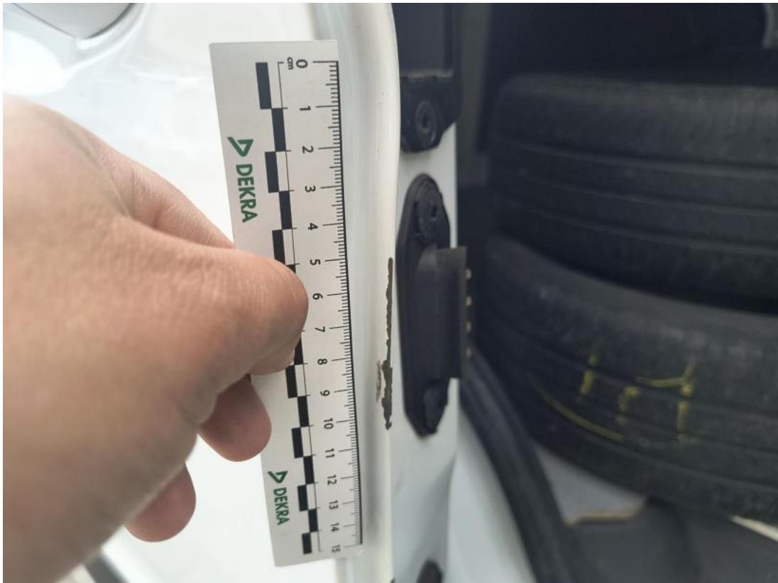
Fot. 51 Drzwi tylne P - Rysa/odprysk 1
