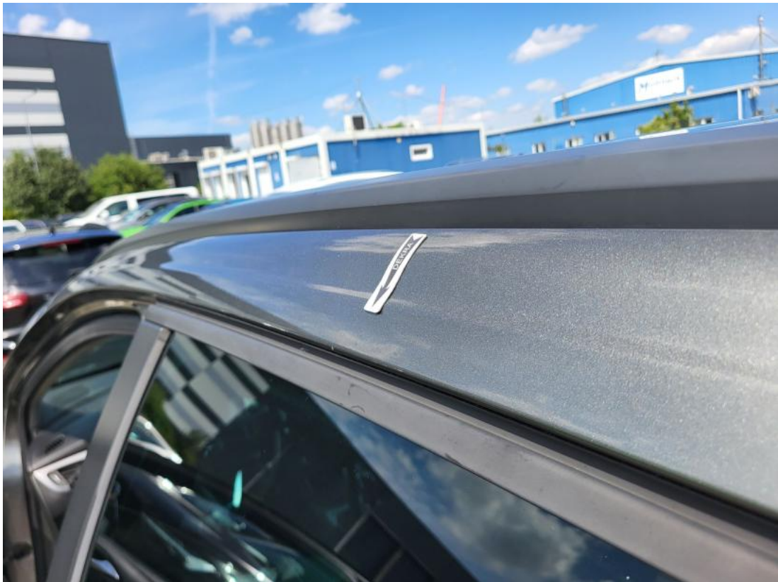
Fot. 53 Rama dachu L - Wgniecenie/odkształcenie 1
