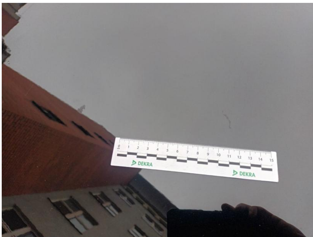
Fot. 42 Dach - zdjęcie poglądowe 1
