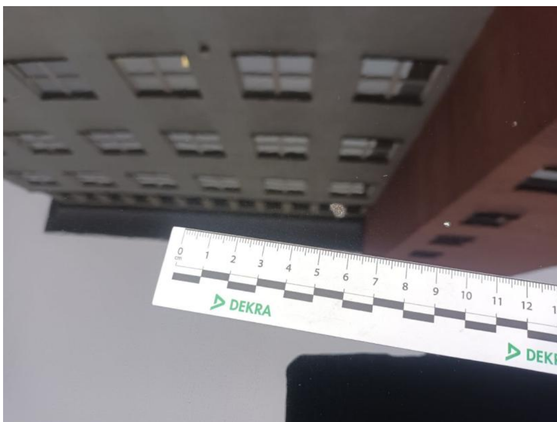
Fot. 46 Dach() - Rysa/odprysk 3
