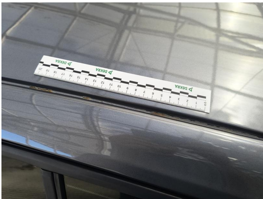
Fot. 57 Dach - Inne 1
