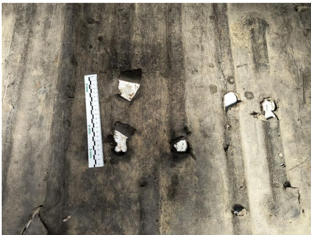
Fot. 110 Podłoga - Pęknięcie/rozerwanie 1
