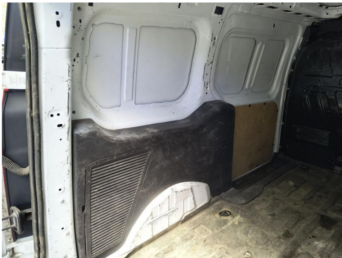
Fot. 113 Ściana lewa - Rysa/odprysk 1
