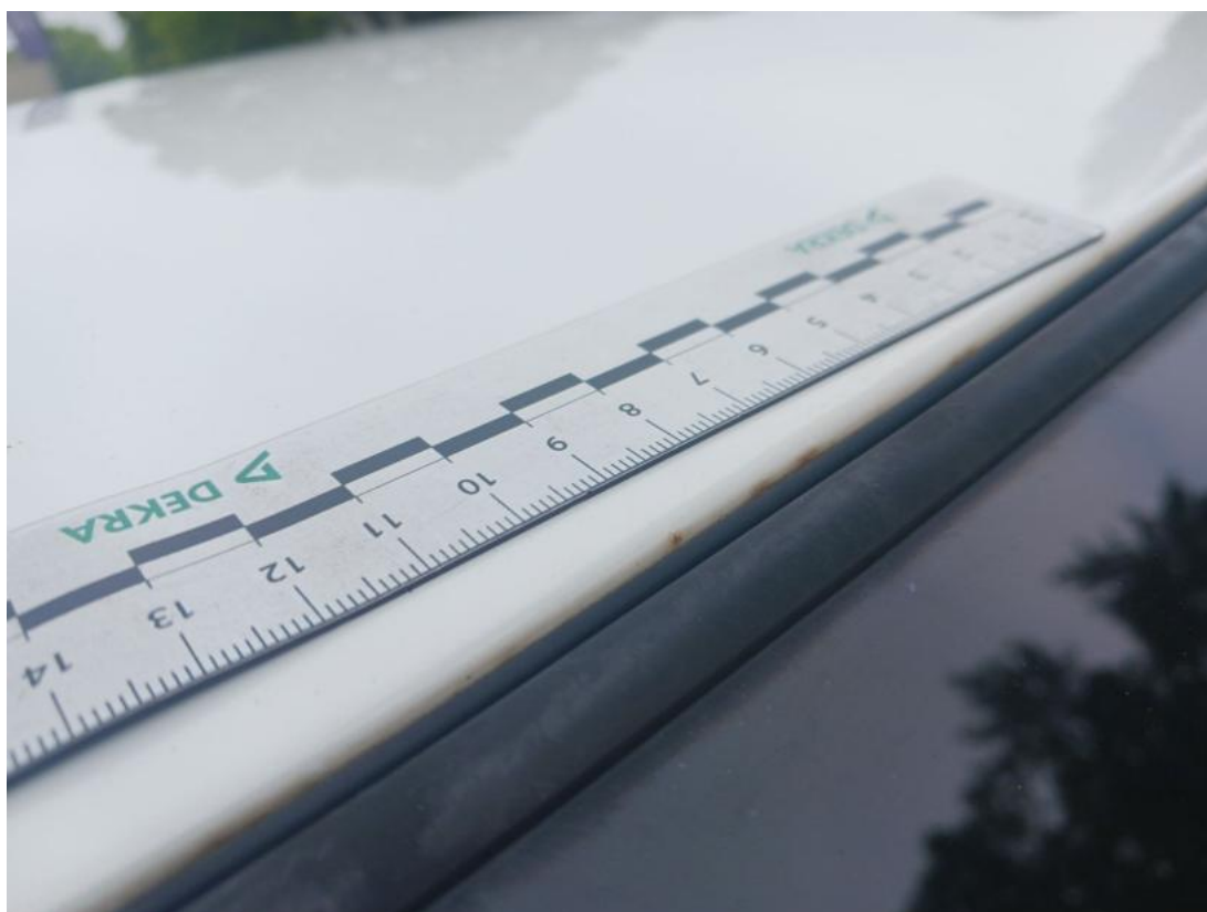
Fot. 49 Dach - Inne 2
