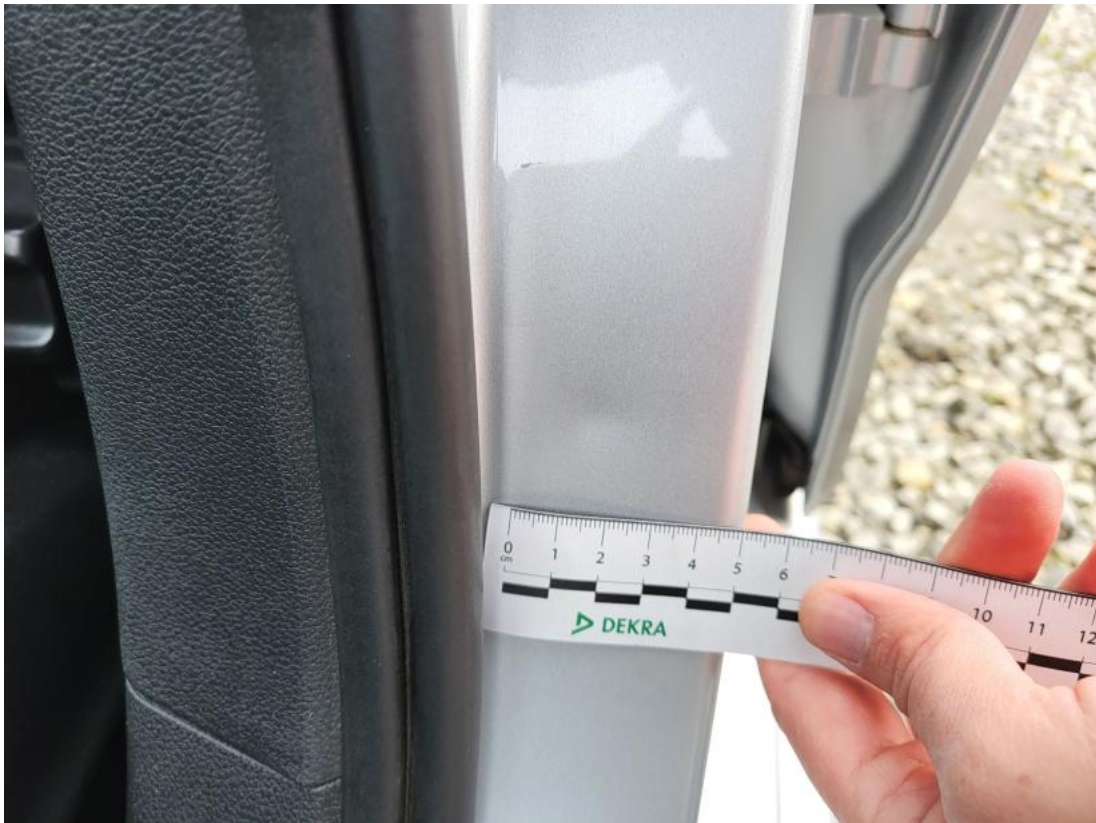
Fot. 41 Słupek środkowy L - Wgniecenie/odkształcenie 1
