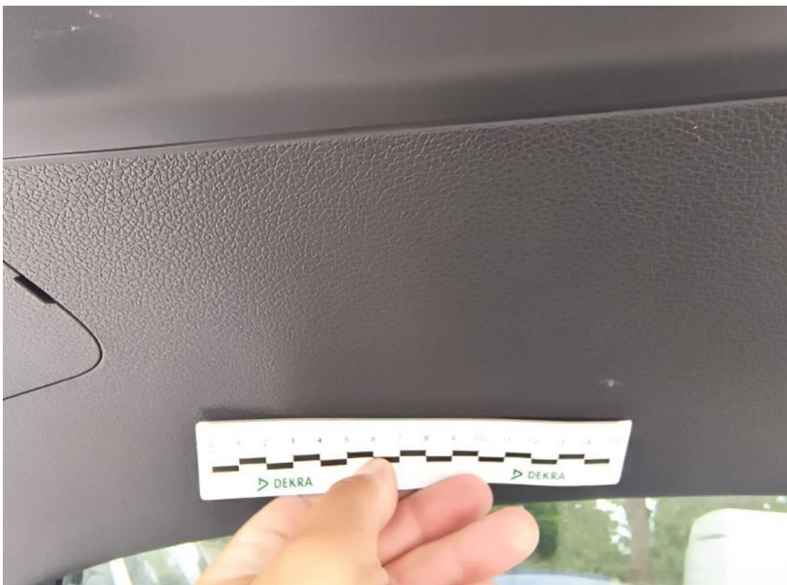
Fot. 68 Wykładzina pokrywy tylnej - Rysa/odprysk 2
