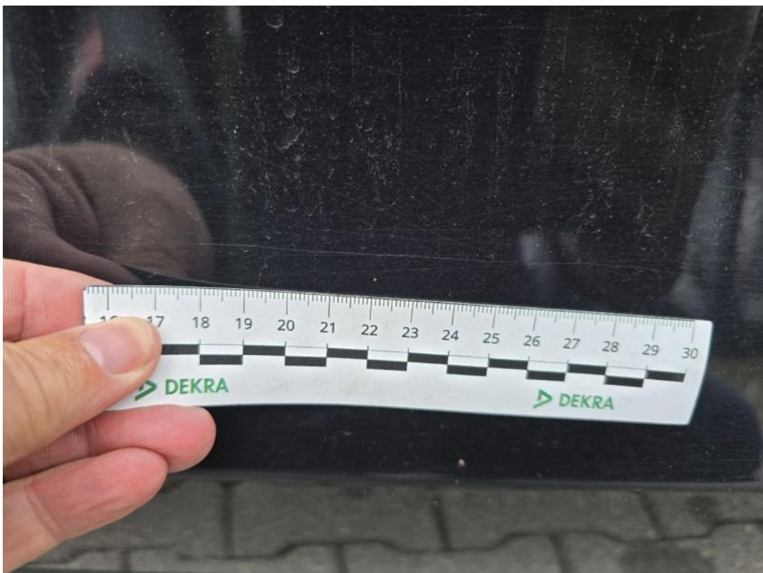
Fot. 46 Drzwi tylne P() - Rysa/odprysk 3
