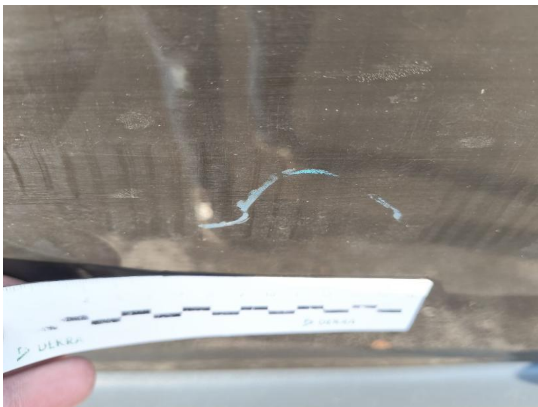
Fot. 58 Drzwi tylne P - Rysa/odprysk 2
