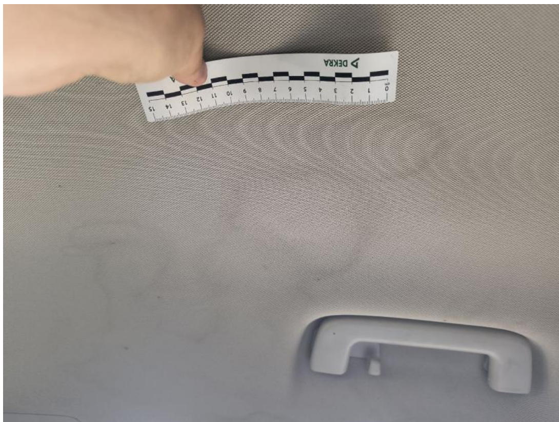
Fot. 77 Podsufitka - Inne 1
