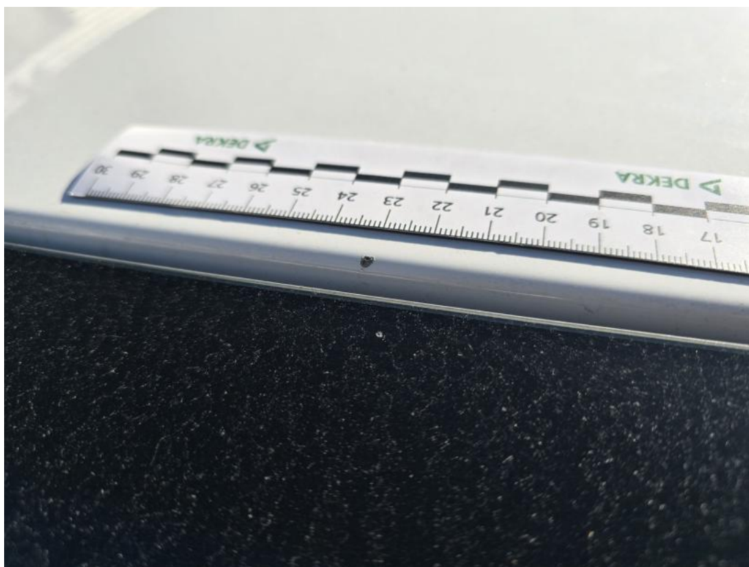
Fot. 38 Dach - Rysa/odprysk 1
