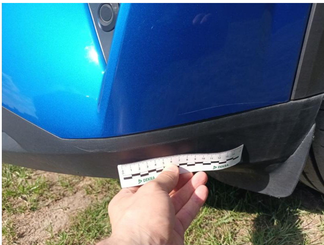
Fot. 39 Zderzak przedni cz dolna - Rysa/odprysk 1
