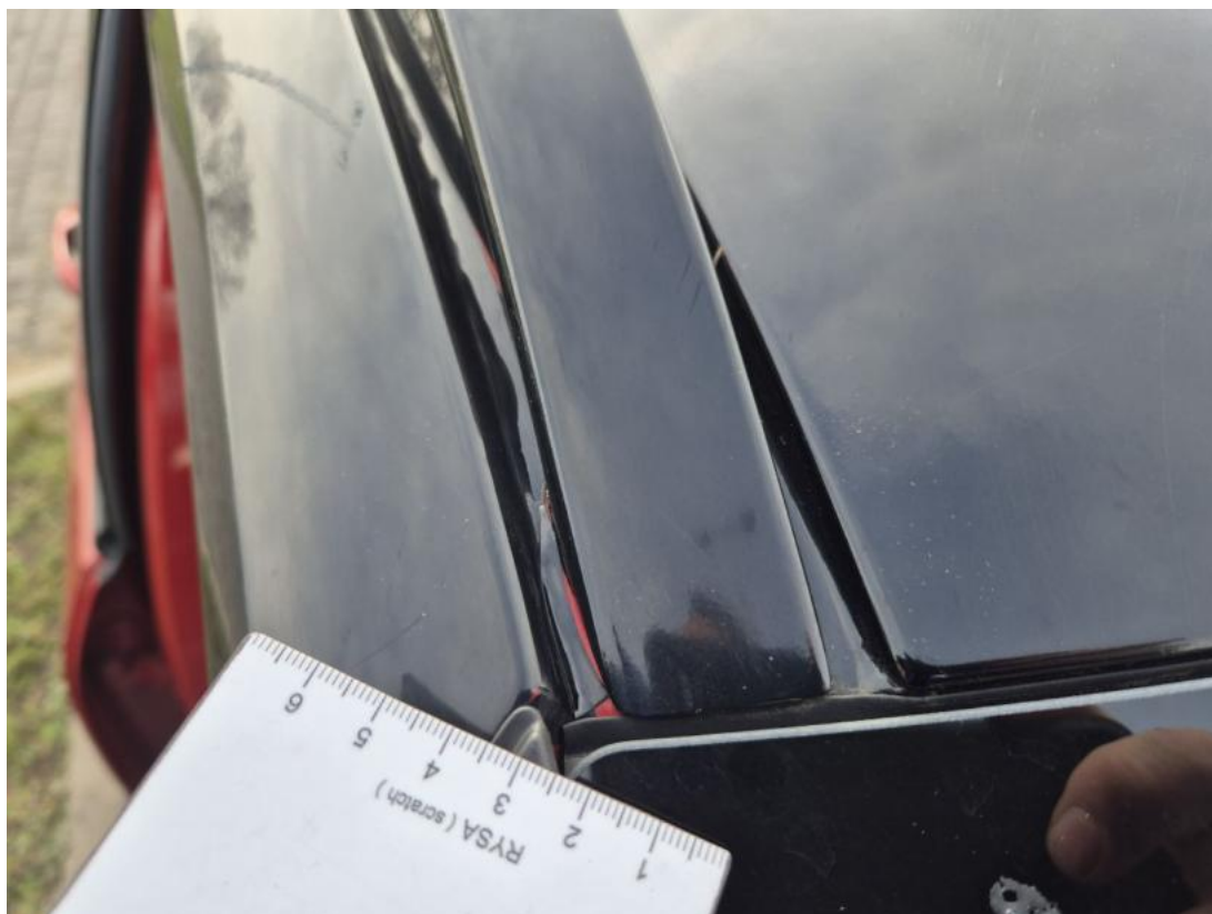
Fot. 51 Dach - Inne 2
