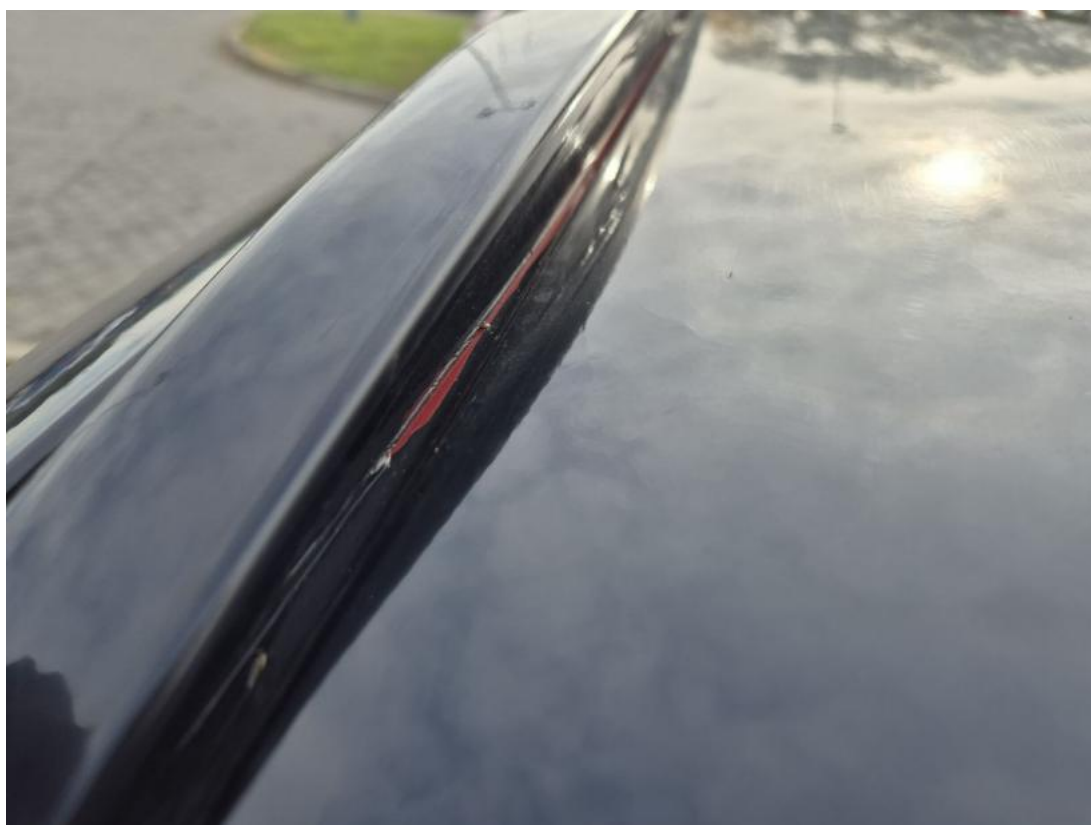
Fot. 52 Dach() - Inne 3
