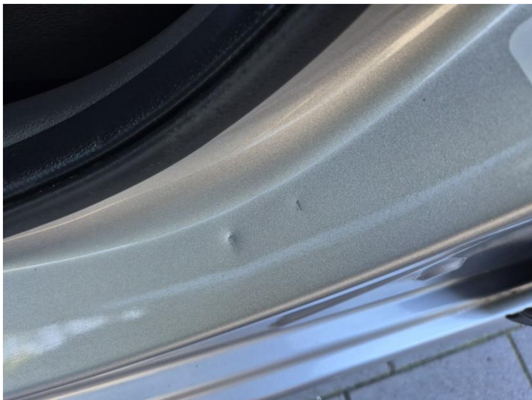
Fot. 41 Słupek środkowy L - Wgniecenie/odkształcenie 1
