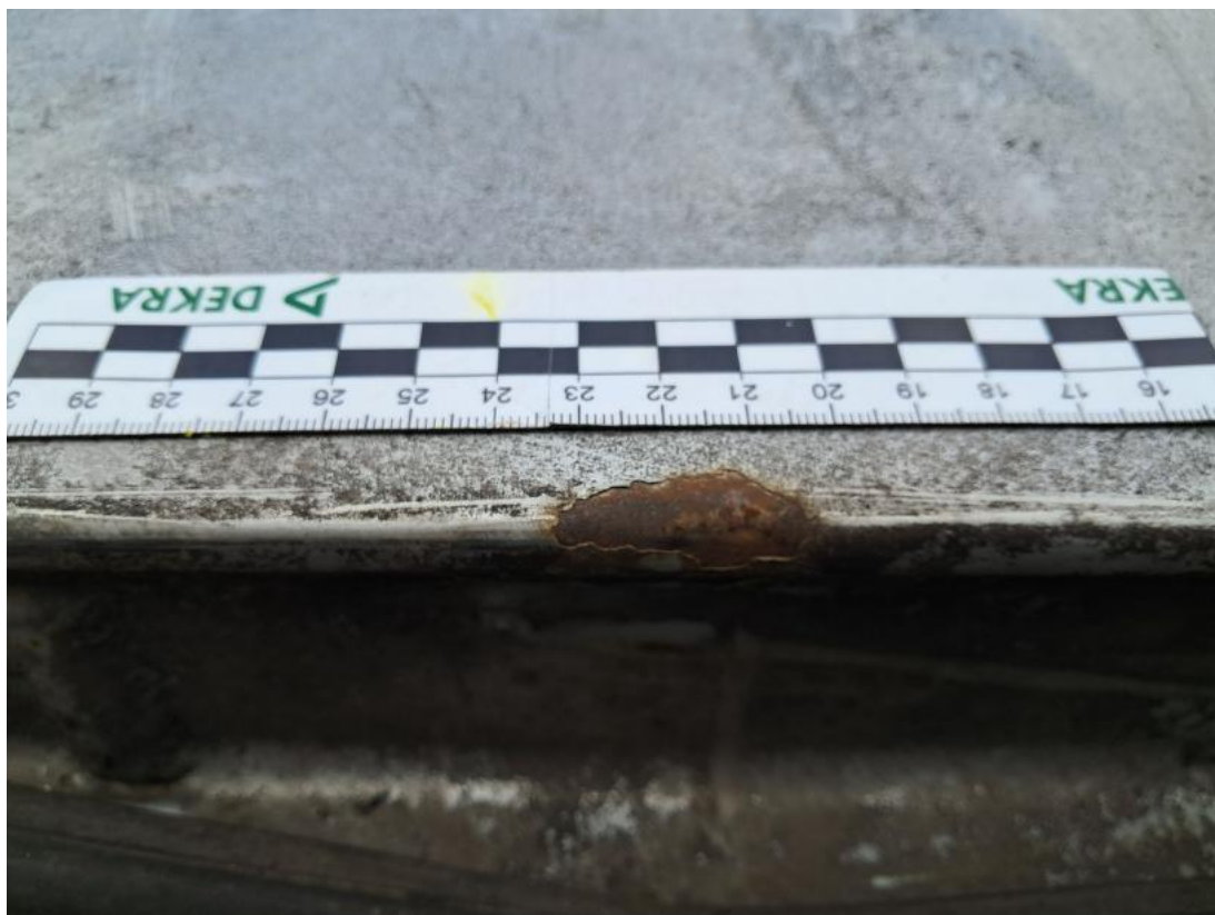
Fot. 53 Dach - Inne 1
