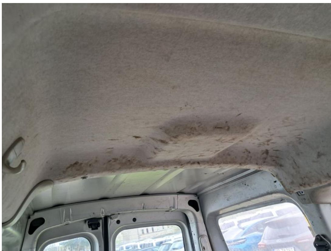
Fot. 80 Podsufitka - Inne 1
