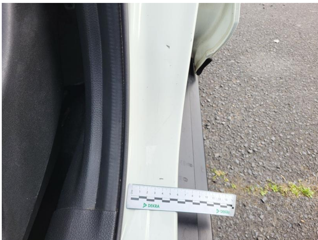
Fot. 52 Słupek środkowy L - Rysa/odprysk 1
