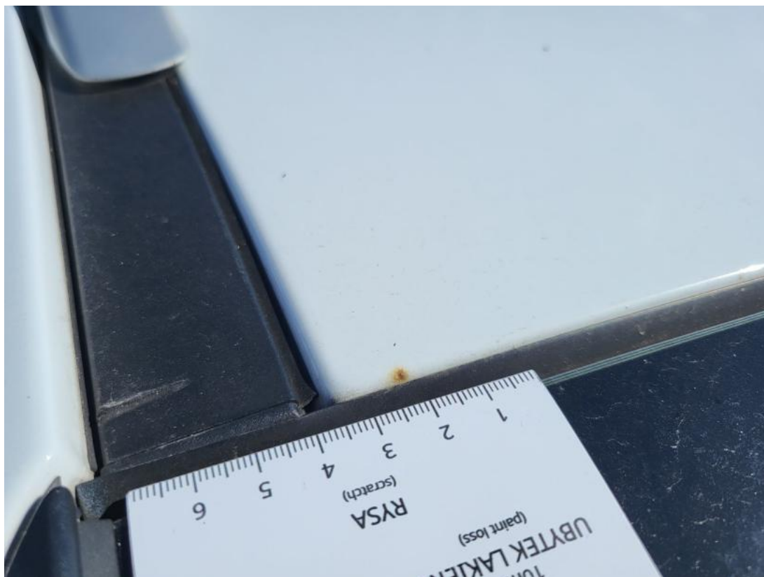
Fot. 51 Dach - Inne 1
