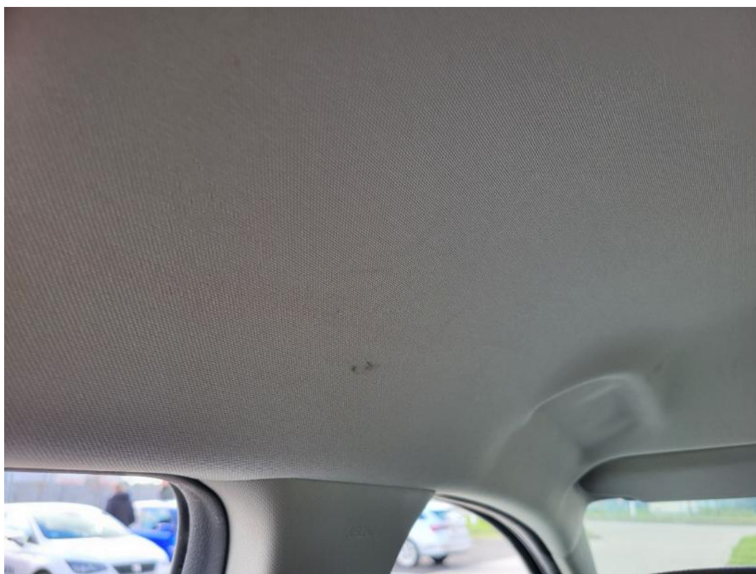
Fot. 50 Podsufitka - Inne 1
