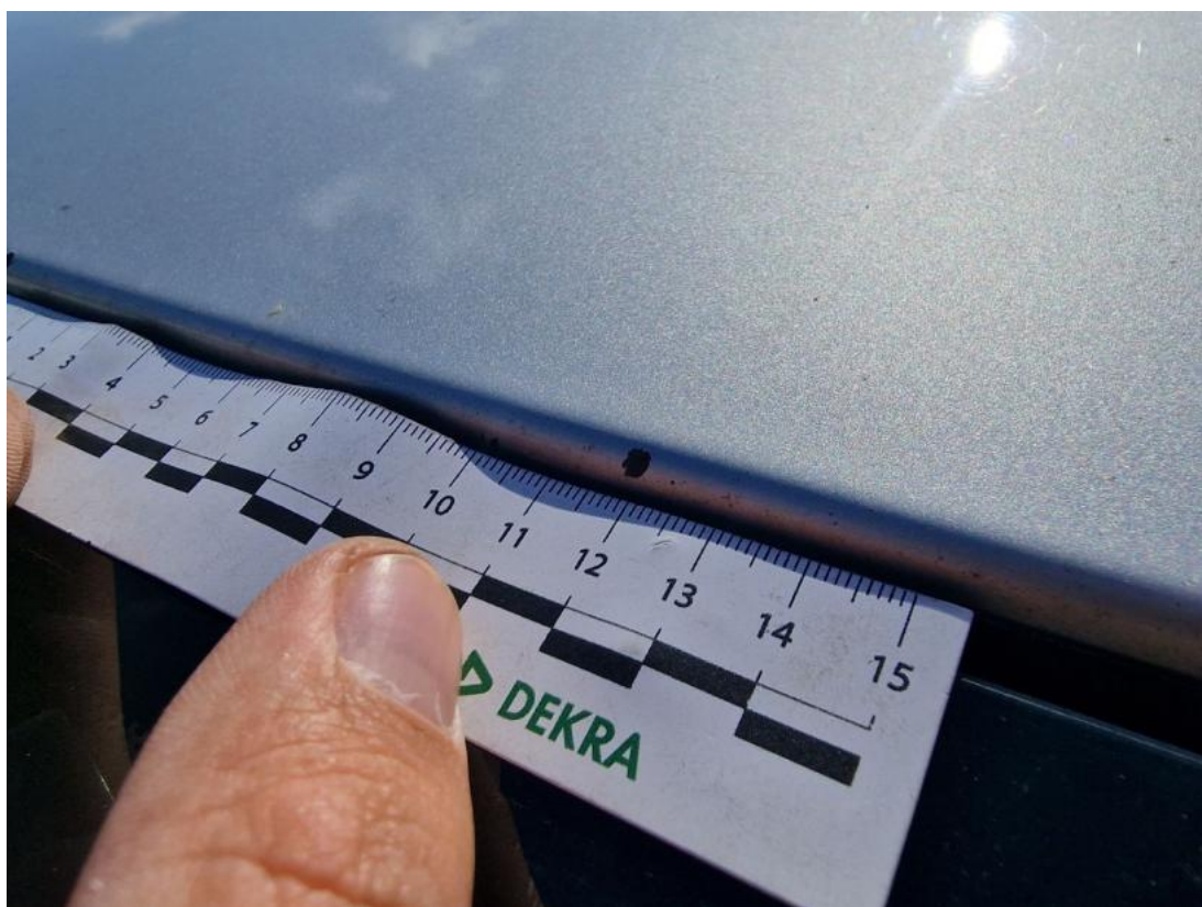
Fot. 62 Dach - zdjęcie poglądowe 2
