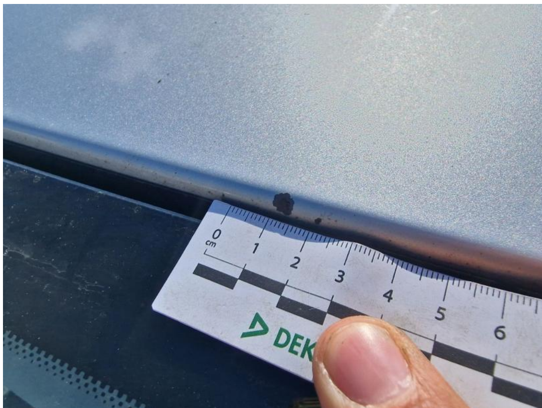
Fot. 61 Dach - zdjęcie poglądowe 1
