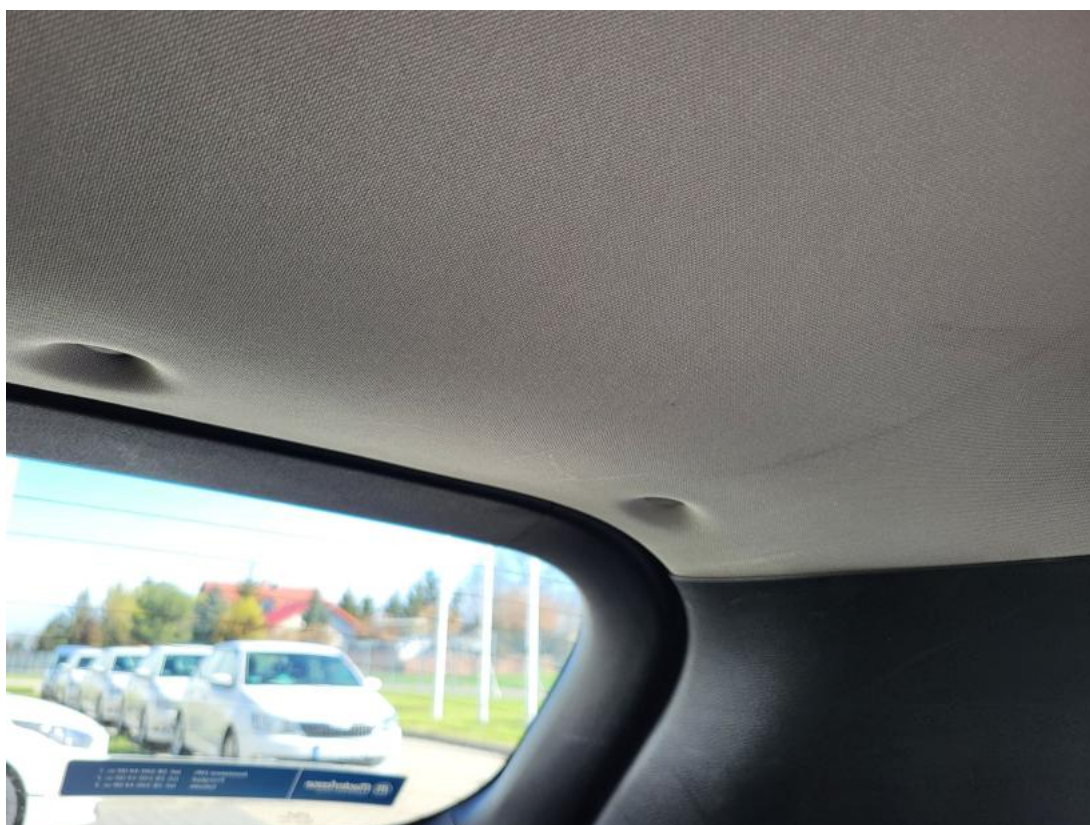
Fot. 38 Podsufitka - Rysa/odprysk 1
