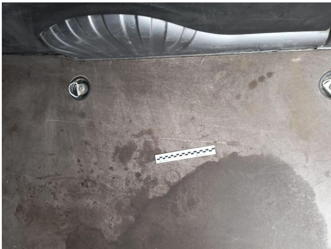
Fot. 101 Podłoga - Rysa/odprysk 1
