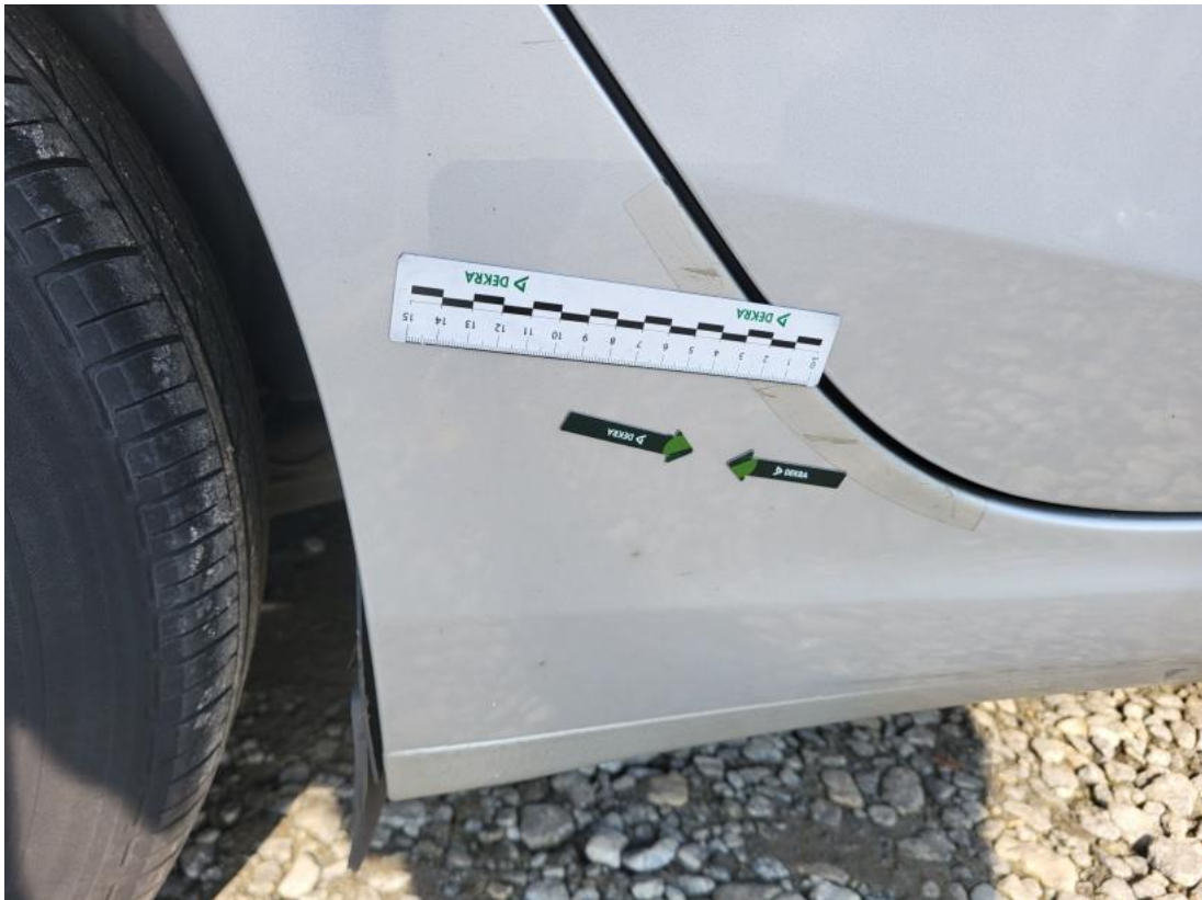
Fot. 39 Próg P - Wgniecenie/odkształcenie 1
