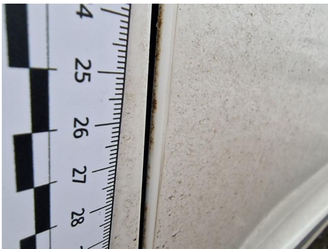
Fot. 58 Drzwi przed L - Inne 2
