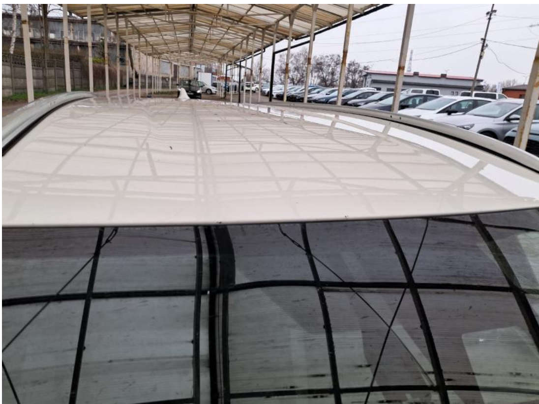
Fot. 46 Dach - zdjęcie poglądowe 1
