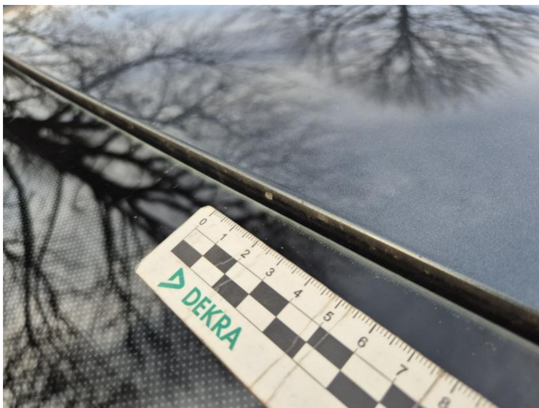
Fot. 42 Dach - Rysa/odprysk 1
