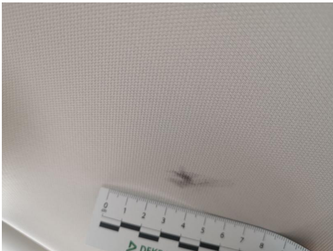
Fot. 89 Podsufitka() - Inne 3
