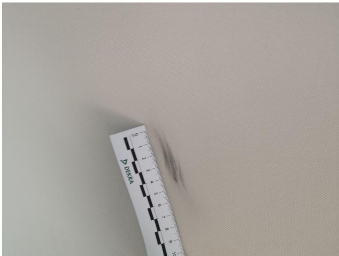
Fot. 87 Podsufitka - Inne 1
