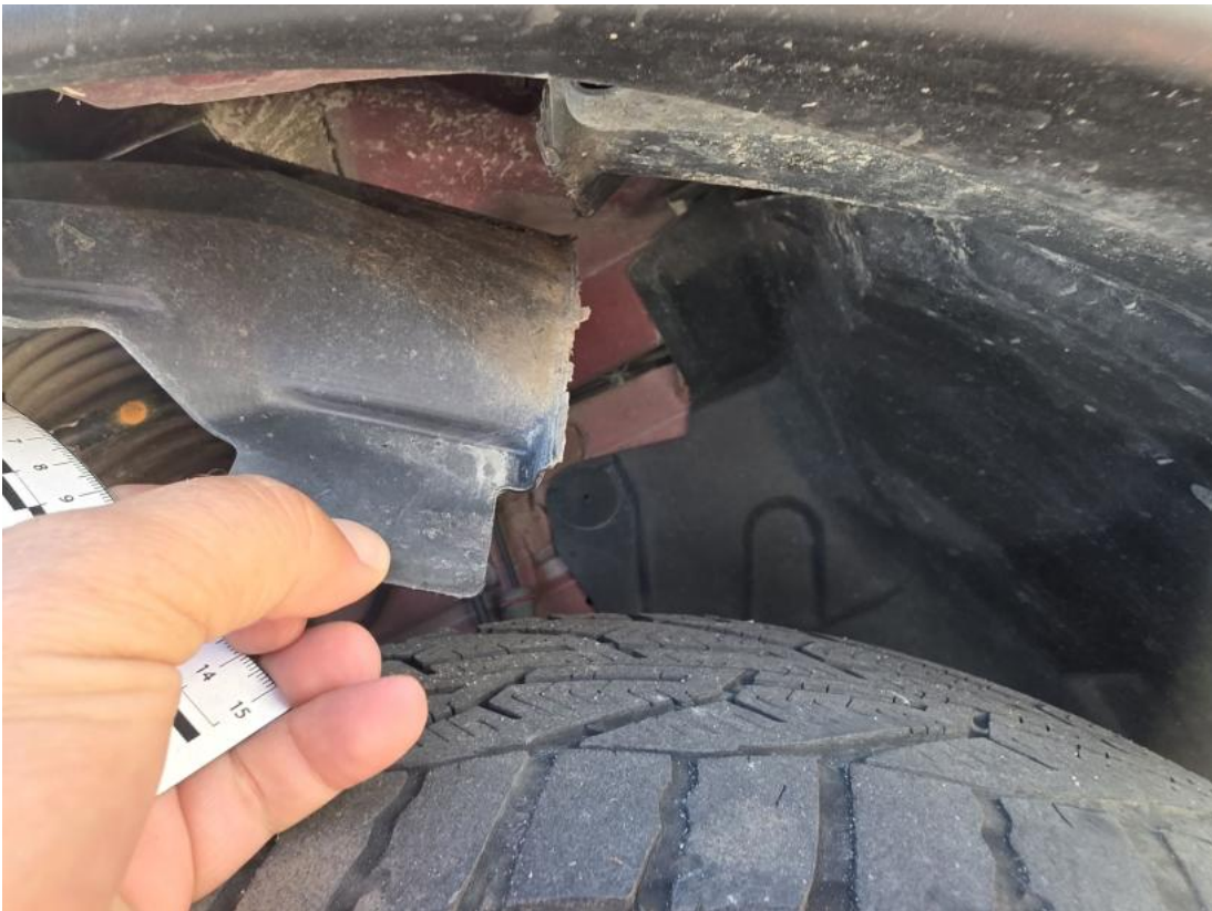
Fot. 53 Nadkole przednie P() - Pęknięcie/rozerwanie 3
