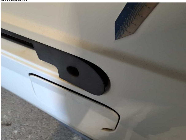
Beschädigung #30: Seitenwand links: Seitenwand (Blende) - verformt - erneuern
