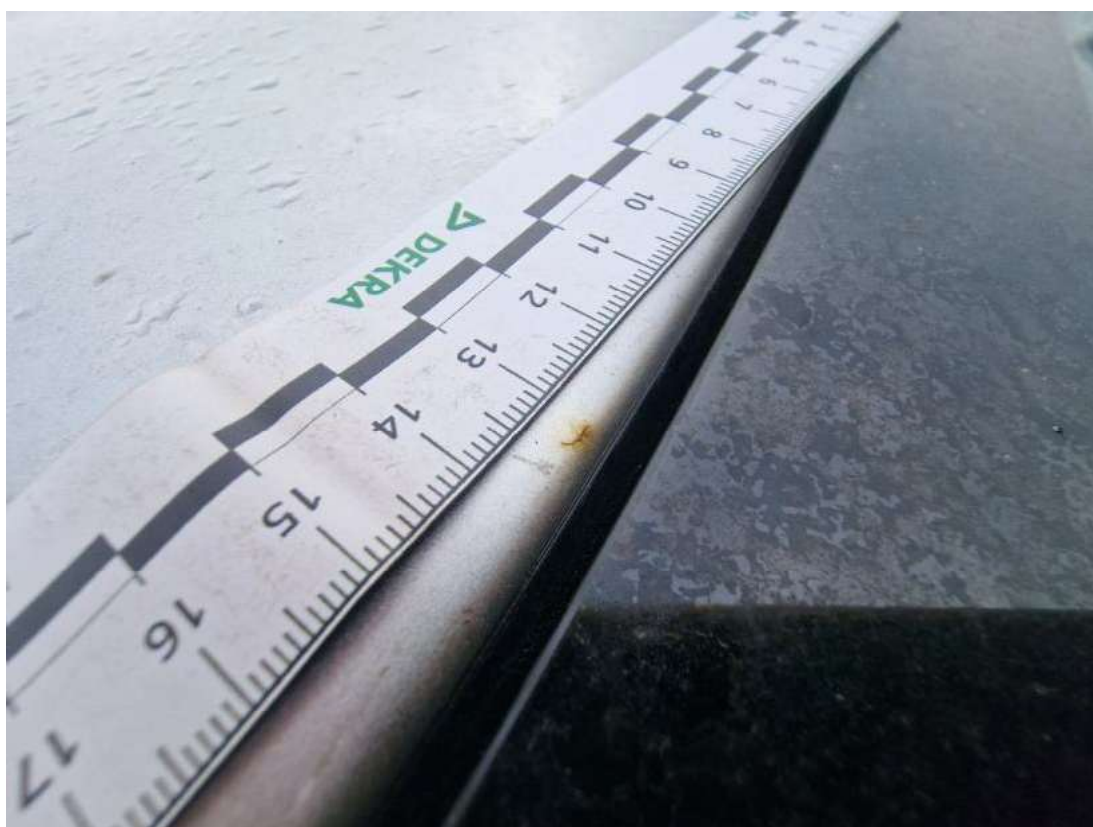
Fot. 58 Dach - Inne 1
