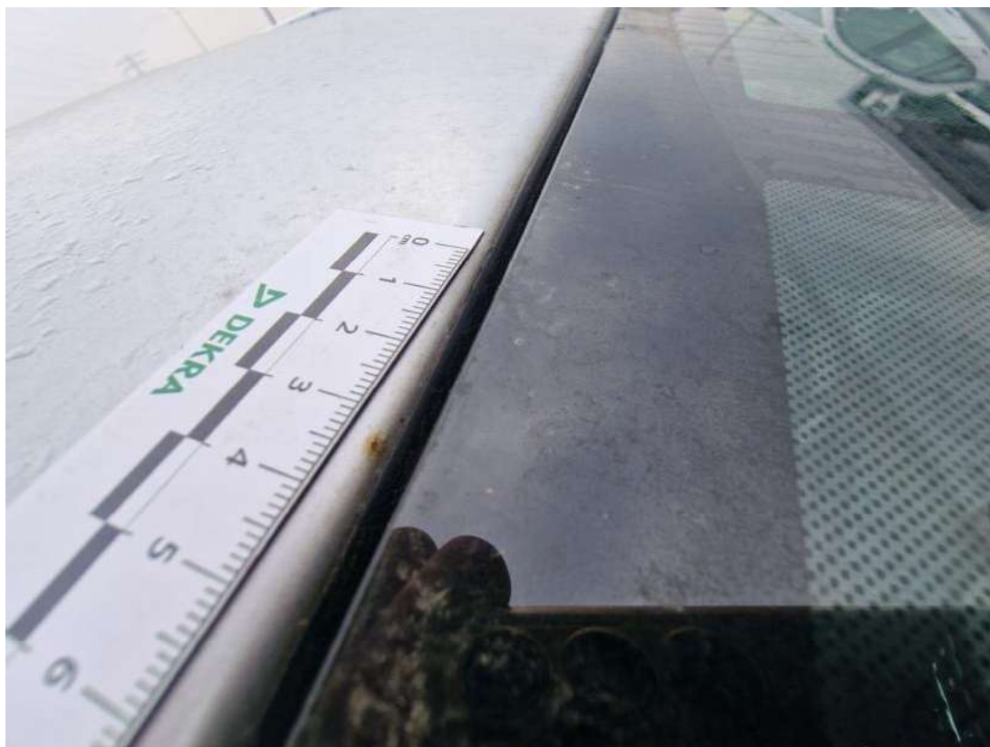
Fot. 57 Dach - zdjęcie poglądowe 2
