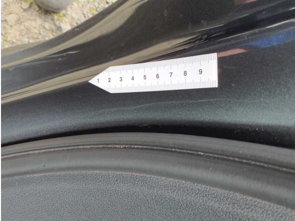
Beschädigung #7: Seitenwand rechts: Einstieg - Kratzer - lackieren
