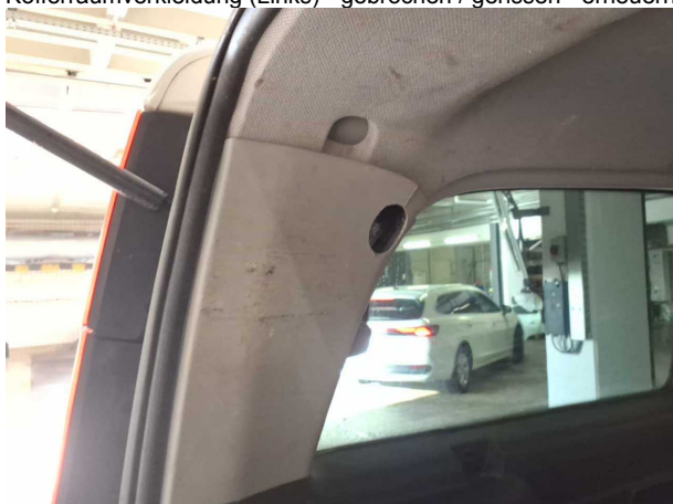
Beschädigung #4: Interieur: Innenraum (Verkleidungen) - Löcher - instandsetzen
