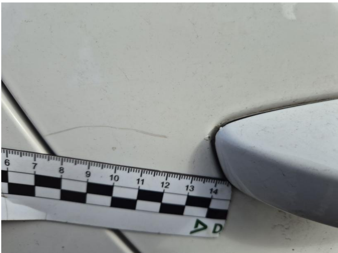
Fot. 38 Drzwi tylne P - Rysa/odprysk 1
