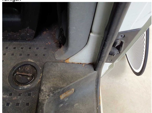
Beschädigung #13: Interieur: Innenraum - Korrosion - instandsetzen und lackieren
