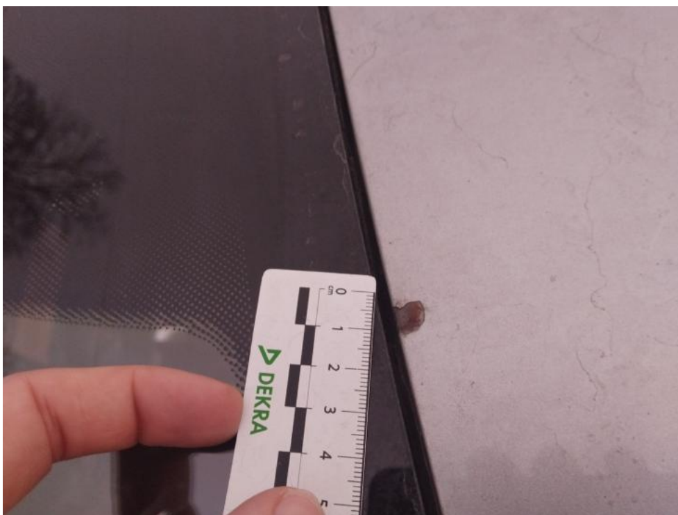
Fot. 69. Dach stały - korozja 1
