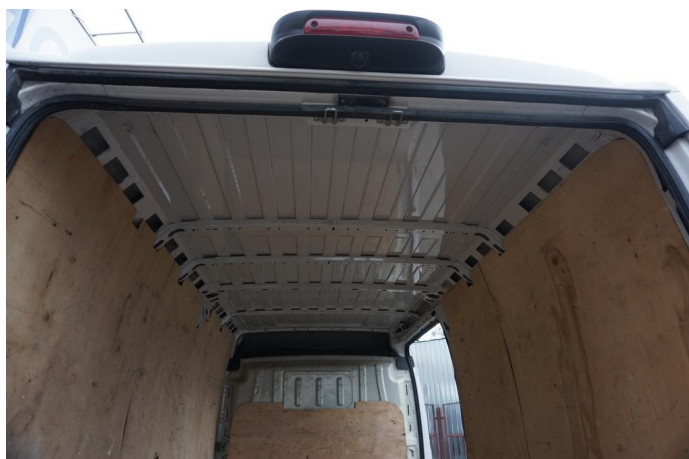
Fot. 48 Fotografia opiniowanego obiektu nr -48
