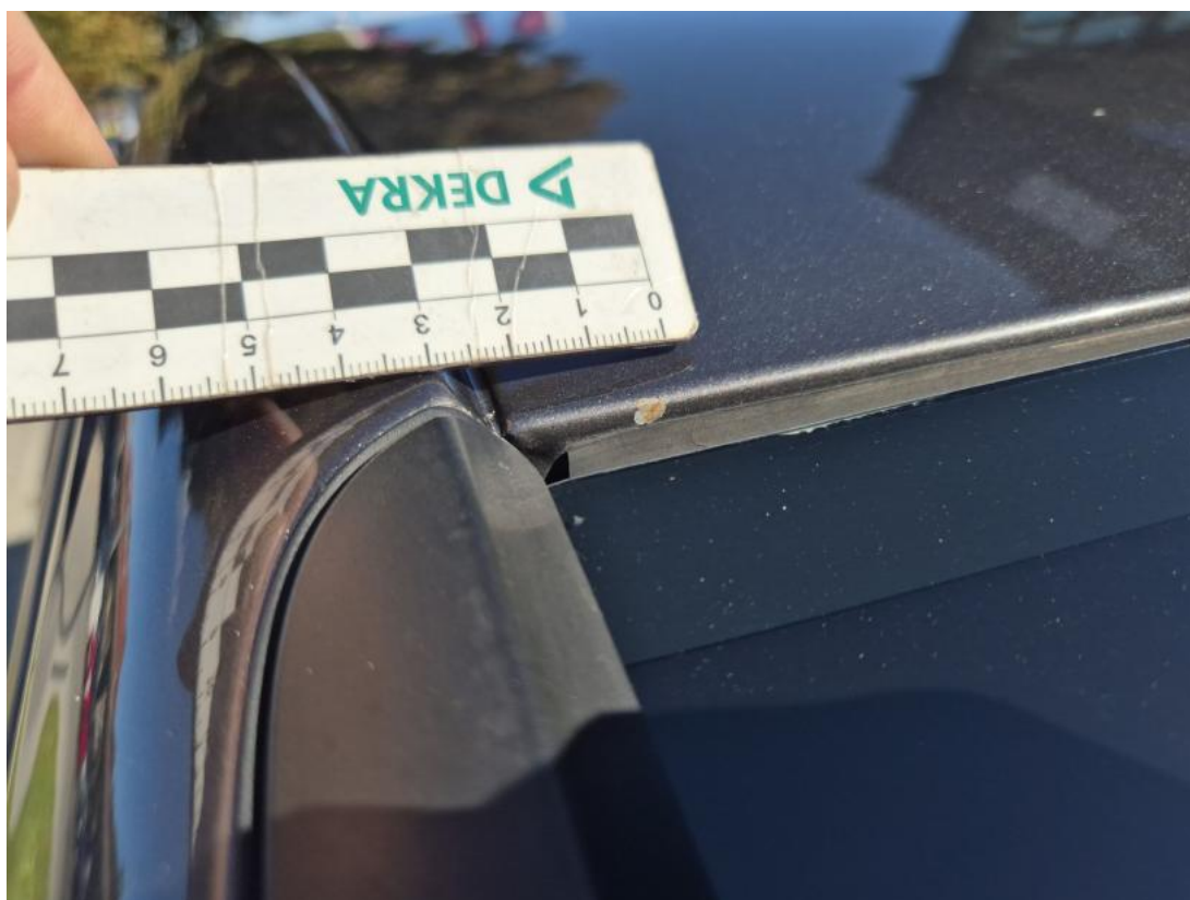
Fot. 38 Dach - Inne 1
