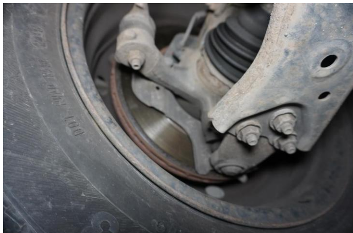
Fot. 43 Fotografia opiniowanego obiektu nr -43
