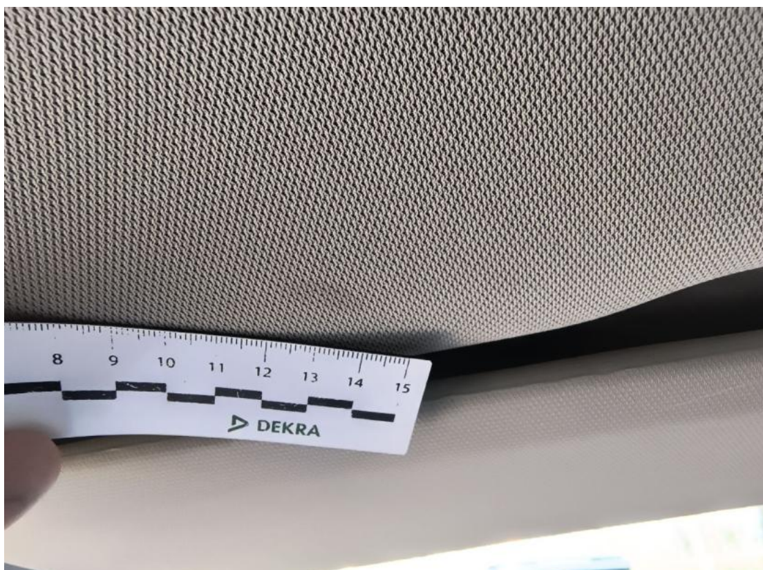
Fot. 102 Podsufitka - Inne 2
