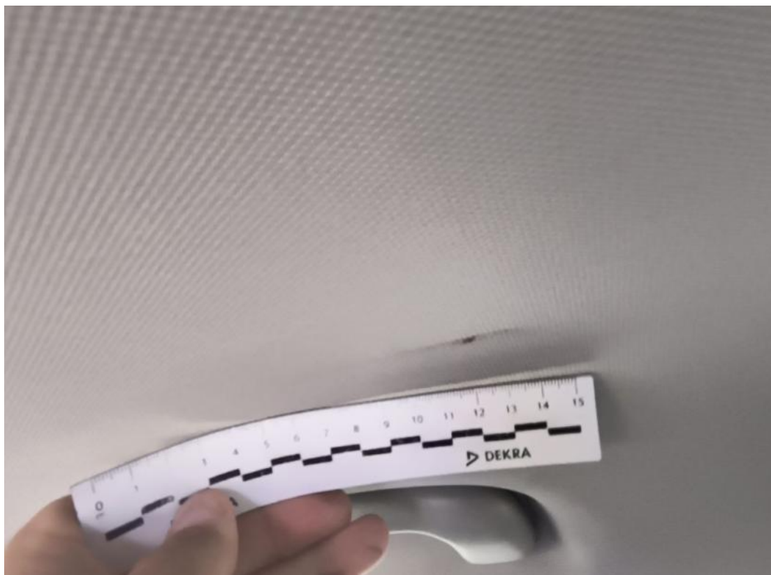
Fot. 101 Podsufitka - Inne 1
