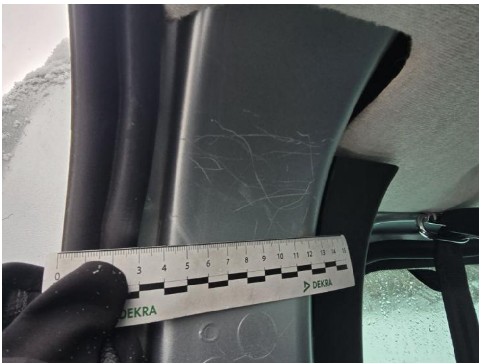
Fot. 54. Ściana lewa - zdjęcie poglądowe 2
