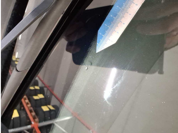
Beschädigung #7: Verglasung: Frontscheibe - gebrochen / gerissen - erneuern
