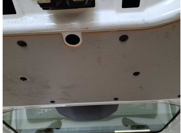
Beschädigung #3: Verkleidungen/Abdeckungen: Heckdeckel, Innenverkleidung - beschädigt - erneuern
