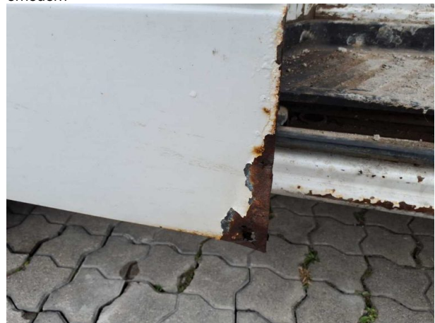
Beschädigung #27: Schiebetür rechts: Schiebetür - Korrosio... erneuern
