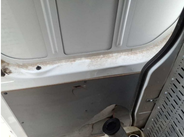
Beschädigung #27: Schiebetür rechts: Schiebetür - Korrosion - erneuern
