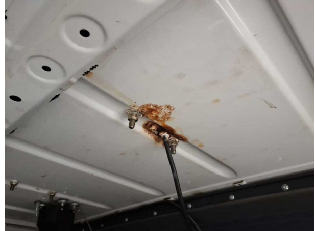
Beschädigung #8: Fahrzeugdach: Dach - Korrosion - Smart Repair
