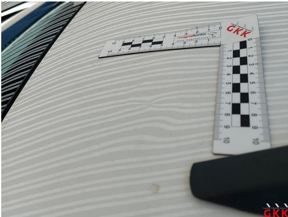
Bild 42 Dach, beschädigt, instand setzen - lackieren
