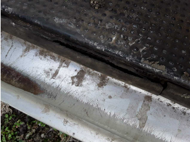
Beschädigung #20: Tür vorn links: Türdichtung - gebrochen / gerissen - erneuern
