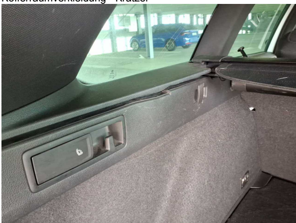
Beschädigung #2: Verkleidungen/Abdeckungen: Kofferraumverkleidung - Kratzer
