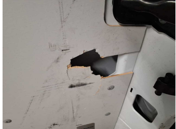
Beschädigung #1: Seitenwand rechts: Innenverkleidung - gebrochen / gerissen - erneuern
