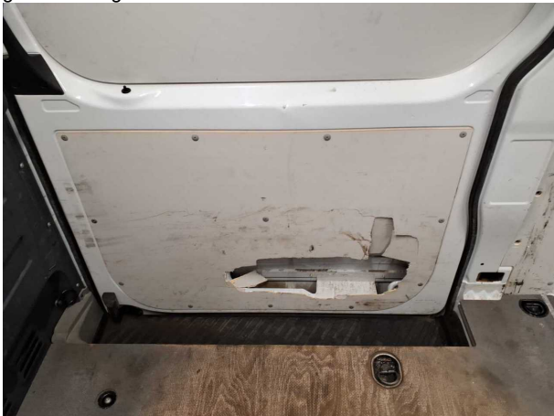
Beschädigung #2: Schiebetür rechts: Verkleidung Standard unten - gebrochen / gerissen - erneuern
