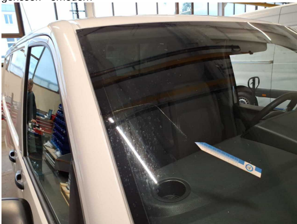
Beschädigung #11: Verglasung: Frontscheibe - gebrochen / gerissen - erneuern
