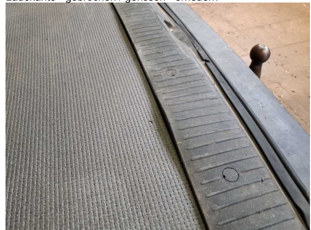
Beschädigung #5: Verkleidungen/Abdeckungen: Verkleidung Ladekante - gebrochen / gerissen - erneuern
