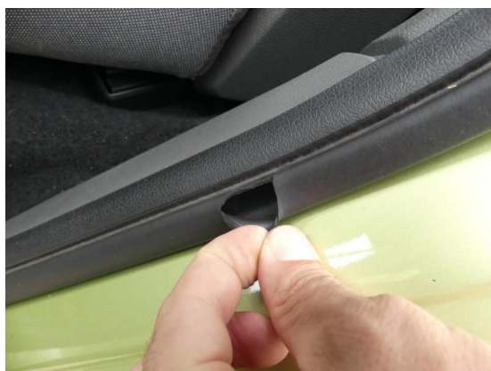
Bild 5: Karosserie / Türdichtung hinten links gerissen
